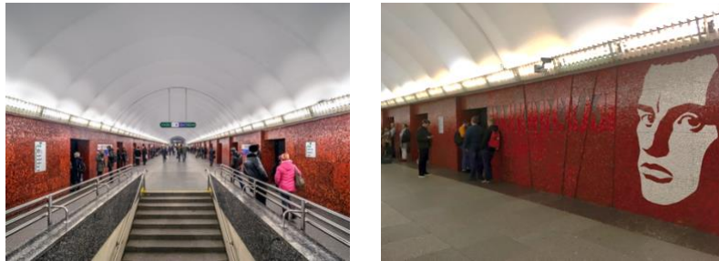
Abbildung 6: Metrostation Mayakovskaya mit den „horizontalen Aufzügen“.
